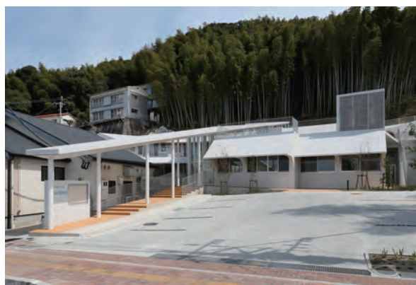
前面道路からの外観
