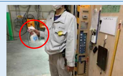
EVの操作盤等の消毒を徹底
