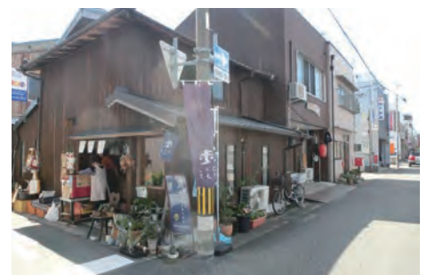
改修された店舗
