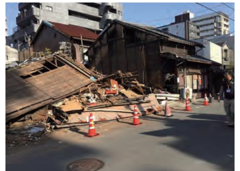
震災で全壊した町家
