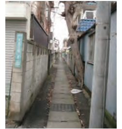
蓋掛け水路の路地
