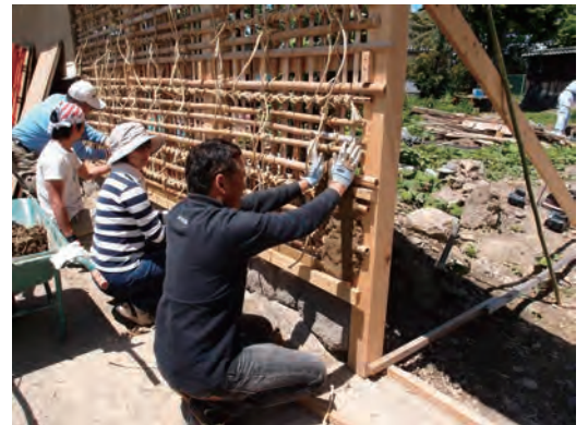
ボランティアによる塀の修理
