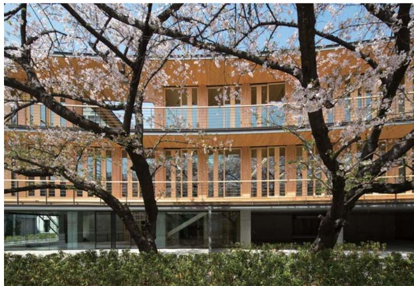
建設地：大阪府大阪市／用途：事務所／構造：木造＋RC造（一部S造、SRC造）／階数：地上3階／面積：敷地面積 1,226.40㎡
