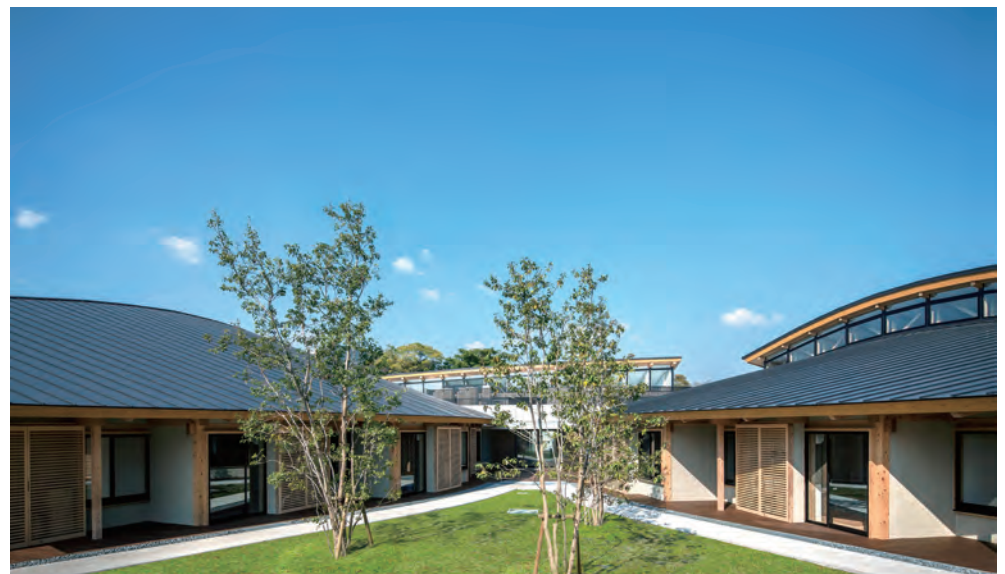
柔らかなフォルムの屋根を持つ教室棟と中庭
