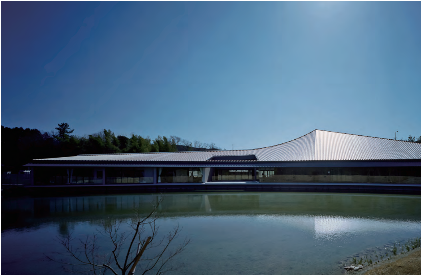
建物北側の修景池越しに見る。水面の水平ラインと揃った軒先は池と同じ円弧状の平面をしている
