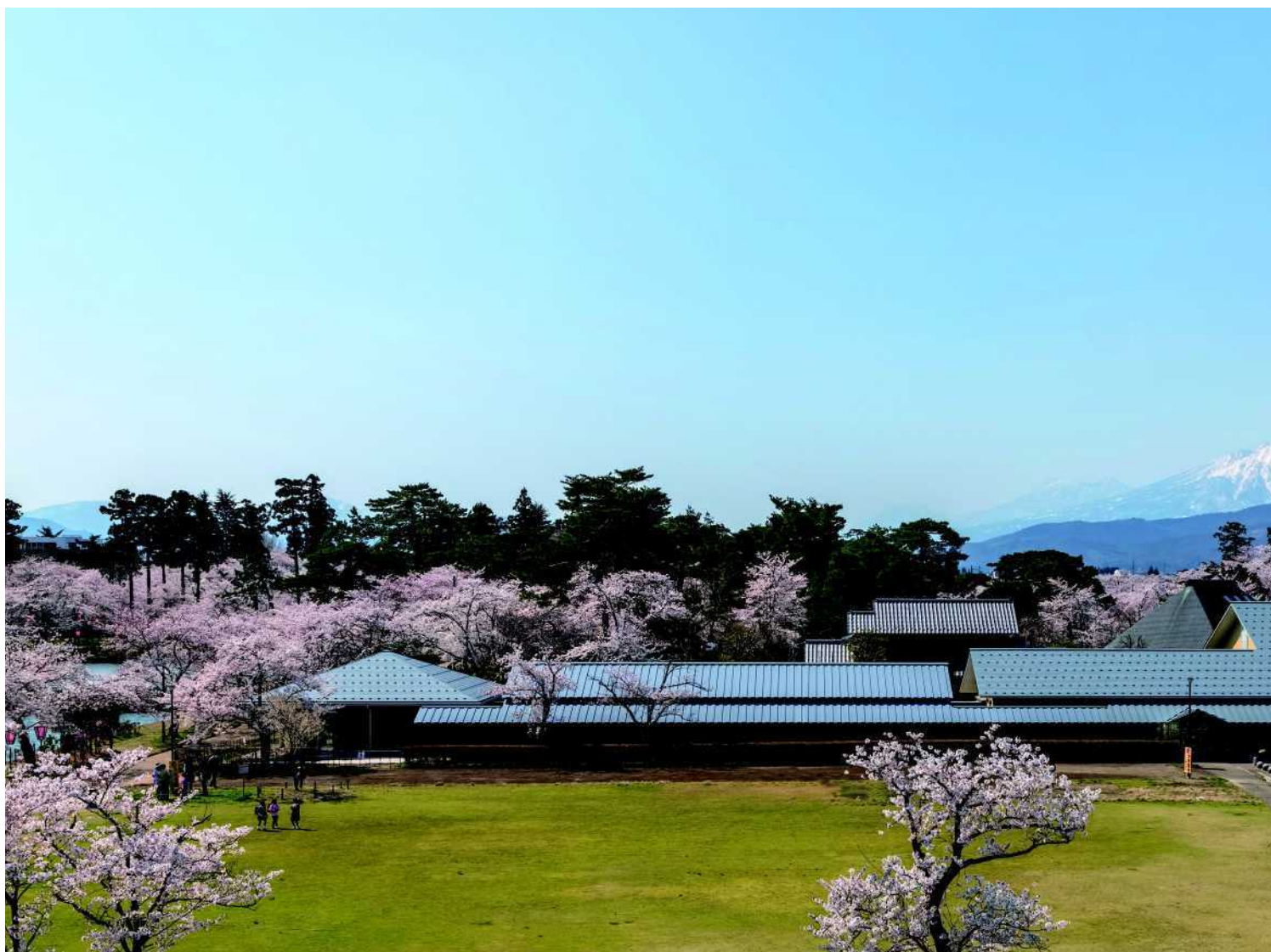
古径邸よりも高さを抑えた切妻屋根の外観
