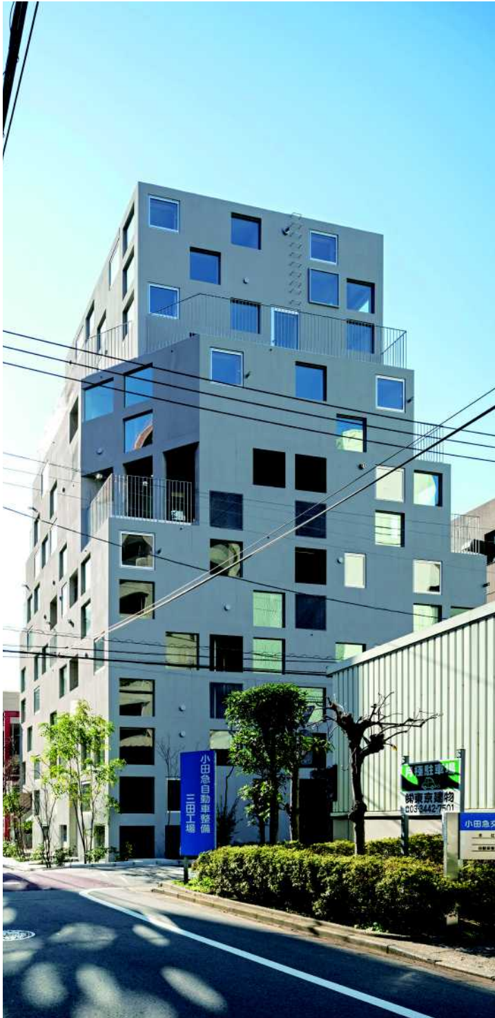
周辺環境となじむスケールとして 1,350mm 間隔で配した 310mm 角の柱梁によるフレームを設定
