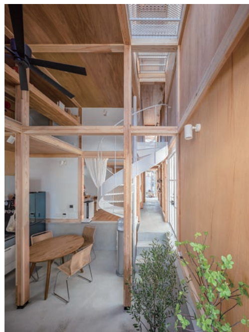
木のグリッドに自由にフロアを架けていく。準防火地域3階建てで120角を用いることで真壁を実現した
