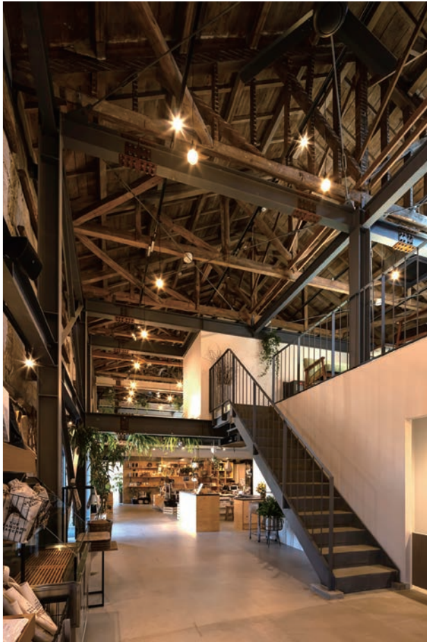
既存躯体を支える鉄骨フレーム
