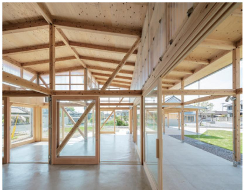
1階の床組を撤去し、構造補強を兼ねて土間コンクリート仕上げに変更したテレワーク棟
