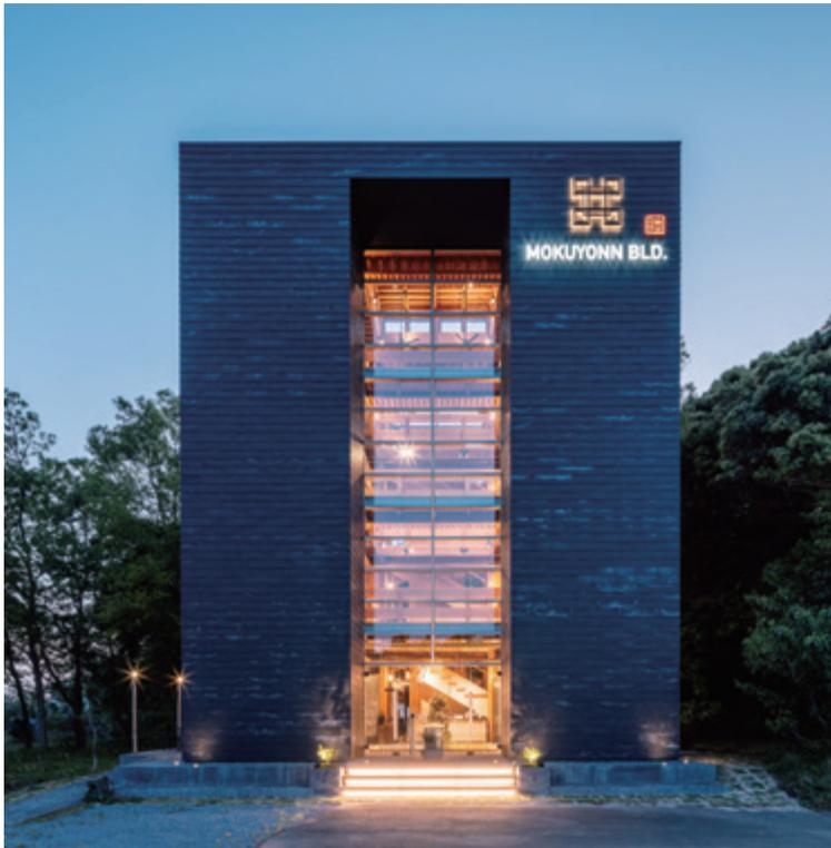
4 隅の構造コアと回廊からなるプランが中央の吹き抜けを介して積層する空間構成
