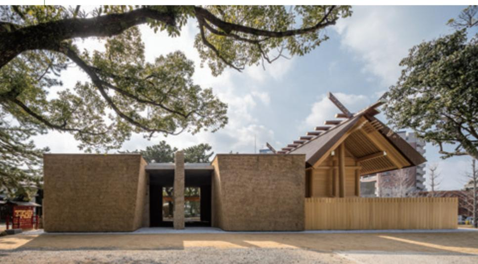
1,800年の歴史を有する神社の式年遷宮における本殿・拝殿の建て替えと仮宮の新設。地域のつながりや氏子意識が薄れゆく風潮の中で、歴史と伝統を踏まえた上で神社を現代に最適化したいという宮司の想いに応えるため、境内の整備と社殿の新設を計画し、再び人々が集う神社の未来を模索した。本殿は高床校倉の神明造りとし、拝殿は御影石と茅壁による祈りの空間である。造営中に使用する仮宮は、光溢れる簡素な県産材架構による木造空間とし、遷宮後も常設とするため、境内の見通しを損ねないよう透過度の高いガラスで囲った。
