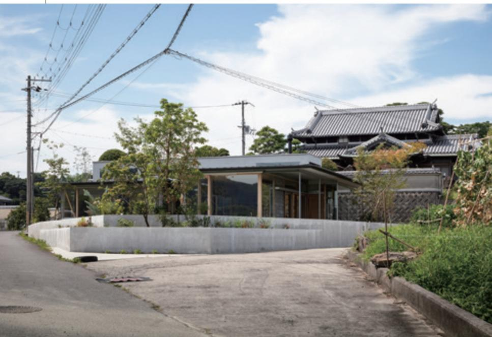
親子3代に渡り、淡路島で農業と牛飼いを生業としてきた家族の住まい。敷地は、田んぼとして利用されていたため、道路と最大1mほどの高低差が生じていた。そこで道路が床レベルとなるように地面を一部掘り起こし、基礎を形成。掘り起こした土を残った敷地に盛土して床から約1mの高さが地面となると、住民が大地と容易に触れられる関係性が生まれた。この床に、北側にある実家の採光や眺望を遮ることがないように水平に伸びる屋根を設け、また周囲からの視線を調整するため、外周の一部に鉄骨造を併用し、軒が深く薄い屋根をデザインした。
