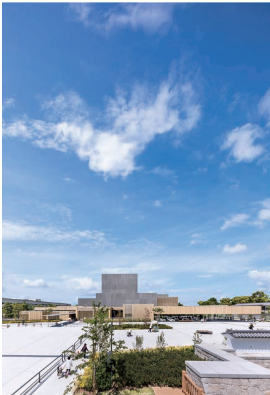
東側外観。公園の木立に溶け込むように内外装には大阪府産材の木ルーバーを張り巡らせた
