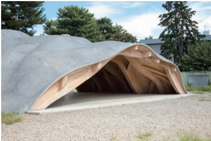
ジグザグに断面を構成することでシェルのデプスをつくり、断面の位相を3層にずらして強度をもたせた
