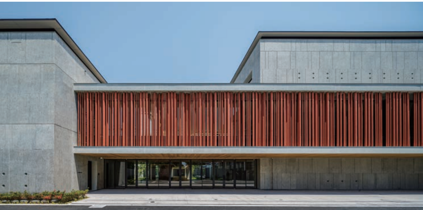
エントランス。日射と外部からの視線をコントロールするテラコッタ風ルーバー
