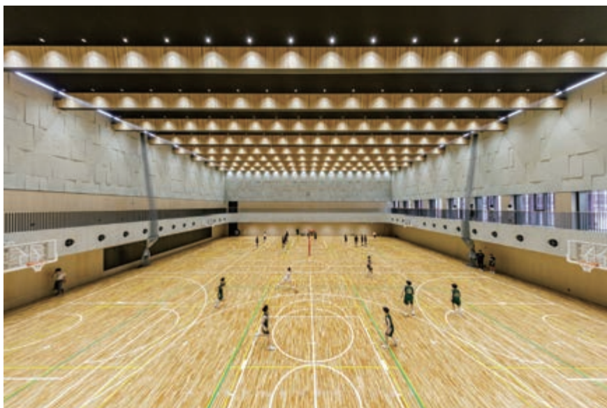
メインアリーナ。音を拡散させる傾斜のついたコンクリート壁。最上部に換気窓
