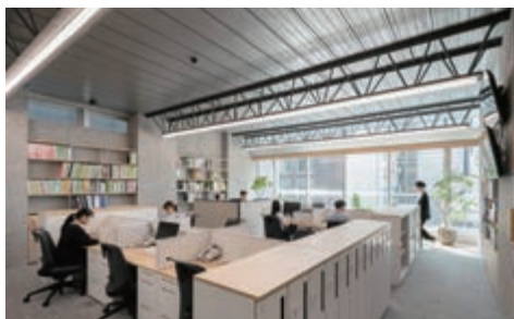
フェローデッキ表しのノイズレスな天井面とライトシェルフにより自然光を引き込む
