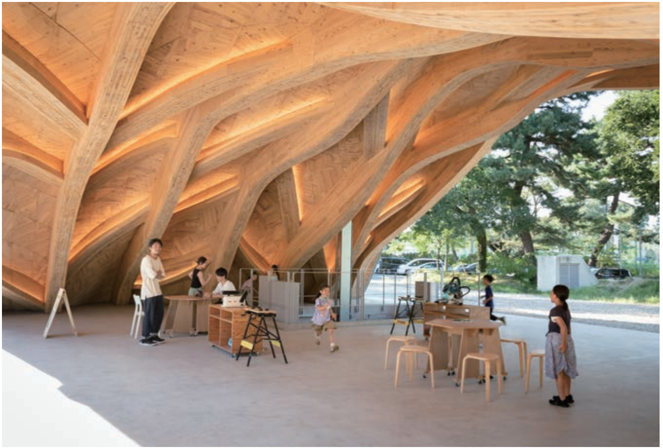
屋根は自然界にみられる葉脈にならった形状
