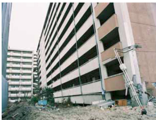
S R C造・ラーメン構造の住棟（11階建て）
