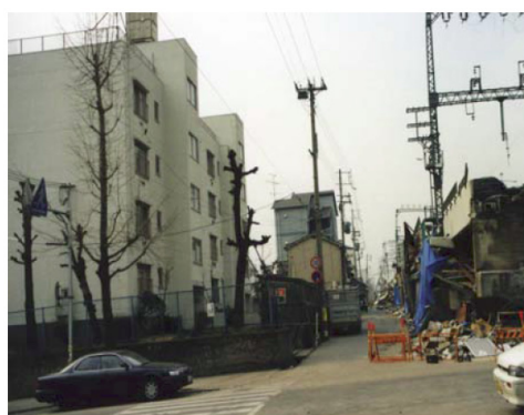
R C造・壁式構造の住棟（4階建て）
