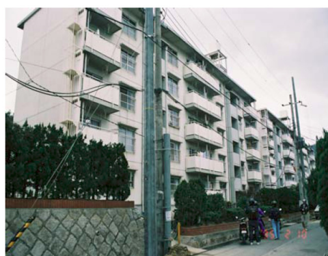
P C板構造の住棟（5階建て）
