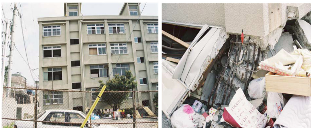
R C造・ラーメン構造の住棟（5階建て）
