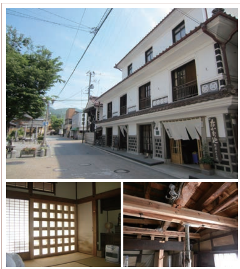
左／国登録有形文化財のなかむらや旅館。太い梁に破損が見られたが、折れた梁の両側に木材を通して挟み込みボルトでつないで一体化し、支柱をあてて補強。さらに客室の和の雰囲気にあわせて化粧格子の耐震壁を追加した。右上／飯坂温泉のシンボルの存在の鱒湖湯。右下／石造りの福島市写真美術館 写真提供：(株)ボーダレス総合計画事務所
